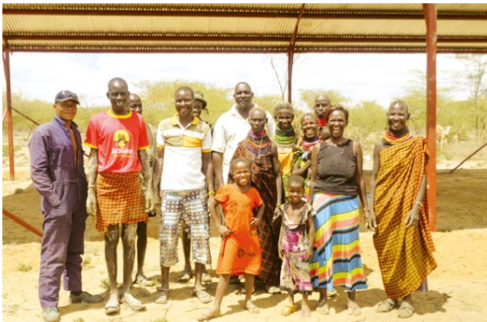
I november hjalp vores medarbejdere den lille menighed med denne tagkonstruktion. De er naturligvis glade for, at de har fået et bedre sted at samles. Der er ofte tæt på 40 graders varme deroppe, så det betyder rigtig meget, at man kan samles i skyggen
