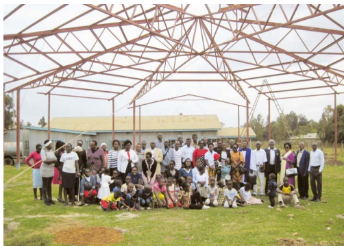
En del af menigheden under de nye spær. I baggrunden ses den gamle kirke af blikplader
