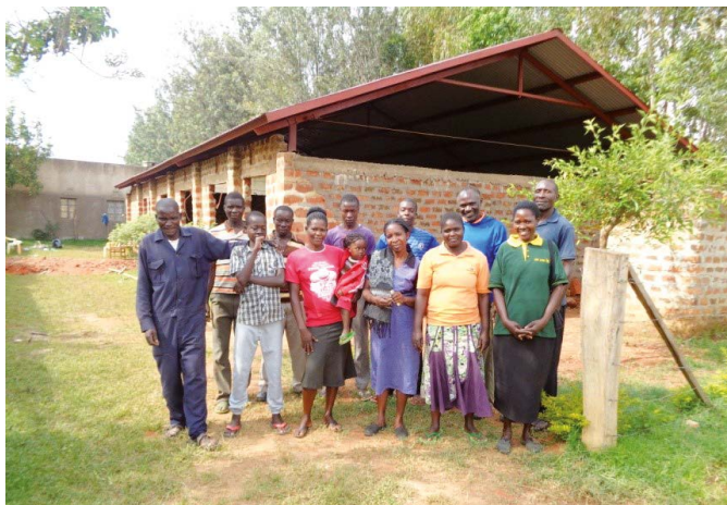
En del af menigheden foran kirken, som de nu kan tage i brug efter at taget er lagt på
