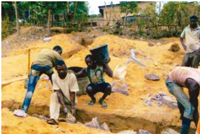
Kimwenza, Congo ved Albertos besøg i juli. Udgravningen til den nye skole er lige begyndt. Alt må gøres ved håndkraft
